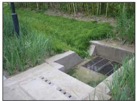
图A9-17 明沟接入沉砂池示意图
