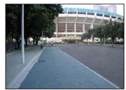
图A9-14 透水水泥混凝土铺装
