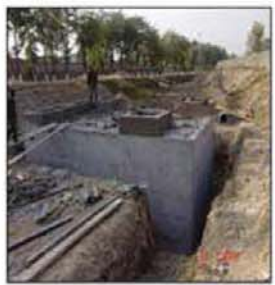
图D6-3 用再生混凝土建造的污水处理设施
