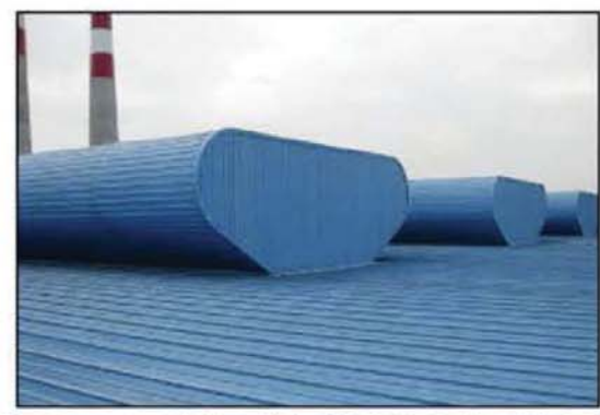
图E10-19 流线型自然通风器示意图
