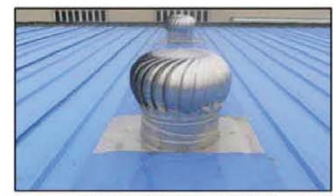
图E10-21 旋流型自然通风器示意图
