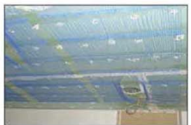
图E9-3 毛细管型辐射板
