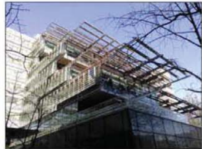
图E8-16 光伏与遮阳一体化实例
